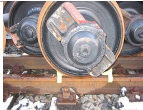
Photo 2 : Stockage en quinconce sur voie à l'aide de cales de sécurité
